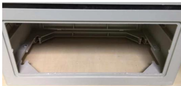
uchycení rozvaděče na tyče
